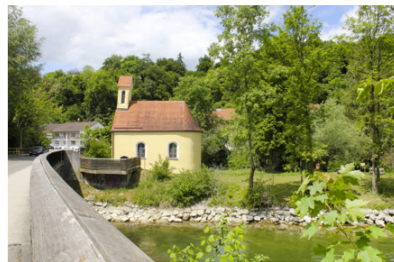
St. Nikolauskapelle an der Amper
