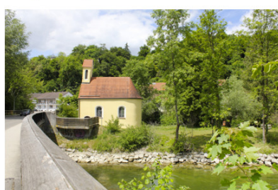
St. Nikolauskapelle an der Amper
