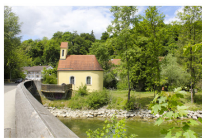
St. Nikolauskapelle an der Amper
