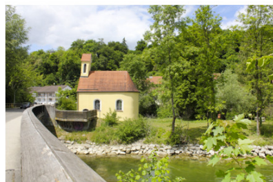
St. Nikolauskapelle an der Amper
